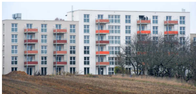
Klare Gliederung der Achsen, einheitlich große Fenster, keine Tiefgarage: Damit ließen sich in dem Gebäude Am Plattenwald in Bad Friedrichshall Baukosten sparen.
