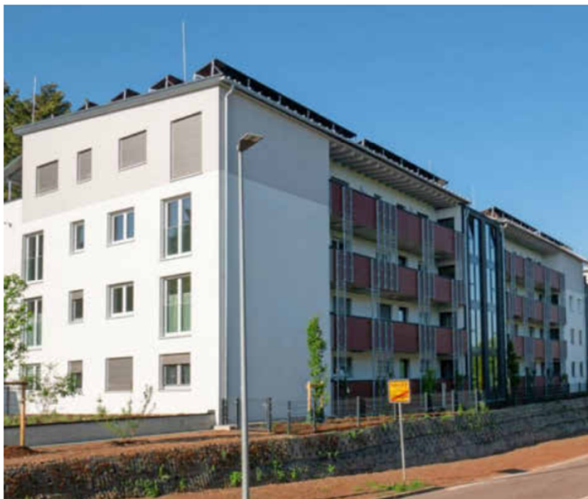
In der Marco-Polo-Straße in Schwaigern hat die Gewo 44 öffentlich geförderte Mietwohnungen gebaut.
