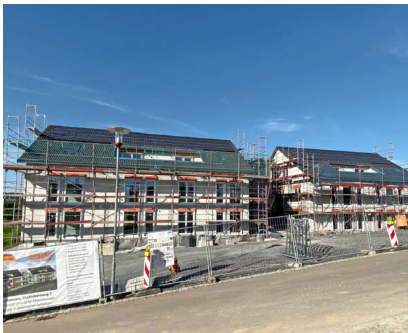
In Massenbachhausen entstehen 14 neue Wohnungen. Bis Ende 2021 sollen sie fertig sein, die Miete soll unter 7,50 Euro pro Quadratmeter liegen. Foto: Gewo Heilbronn
